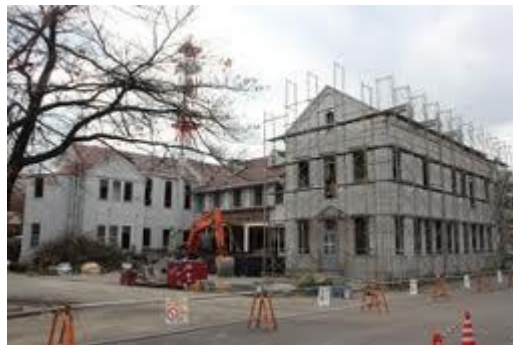
解体中の修道院
