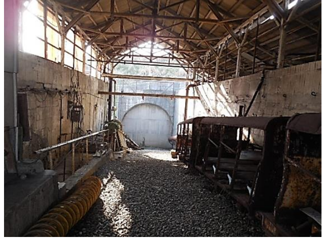
閉山した現在の三池三川坑跡
